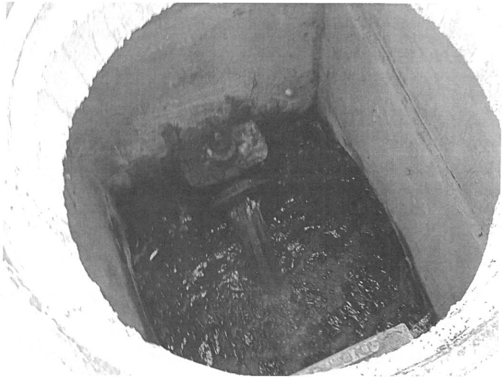
תמונה 5 : ניסיון לסגור את ברוז הניקוז ולקיחת דוגמה נוספת (צולם ע"י חגי טל 22.03.2021)
